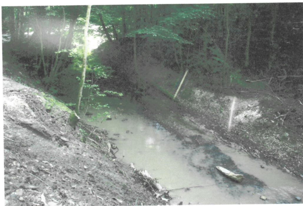
Fot. 8. Profilowanie brzegów oraz wycinka drzew i krzewów - odcinek III
