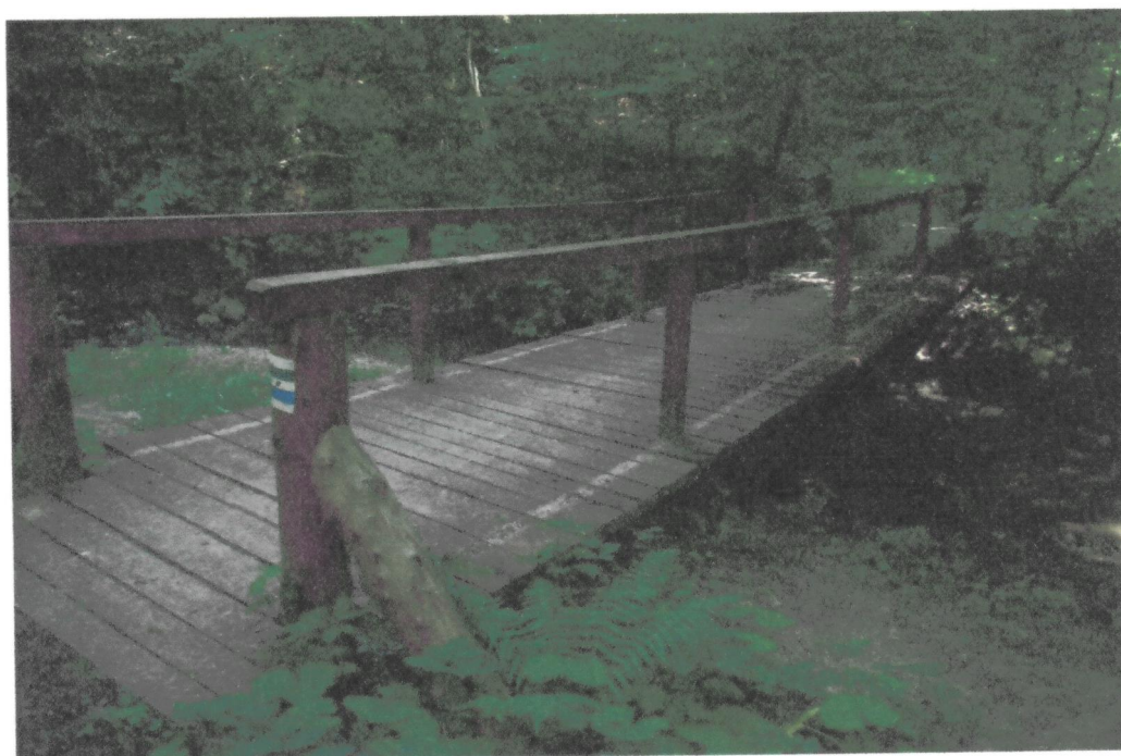
Fot. 5. Kładka/mostek - odcinek V
