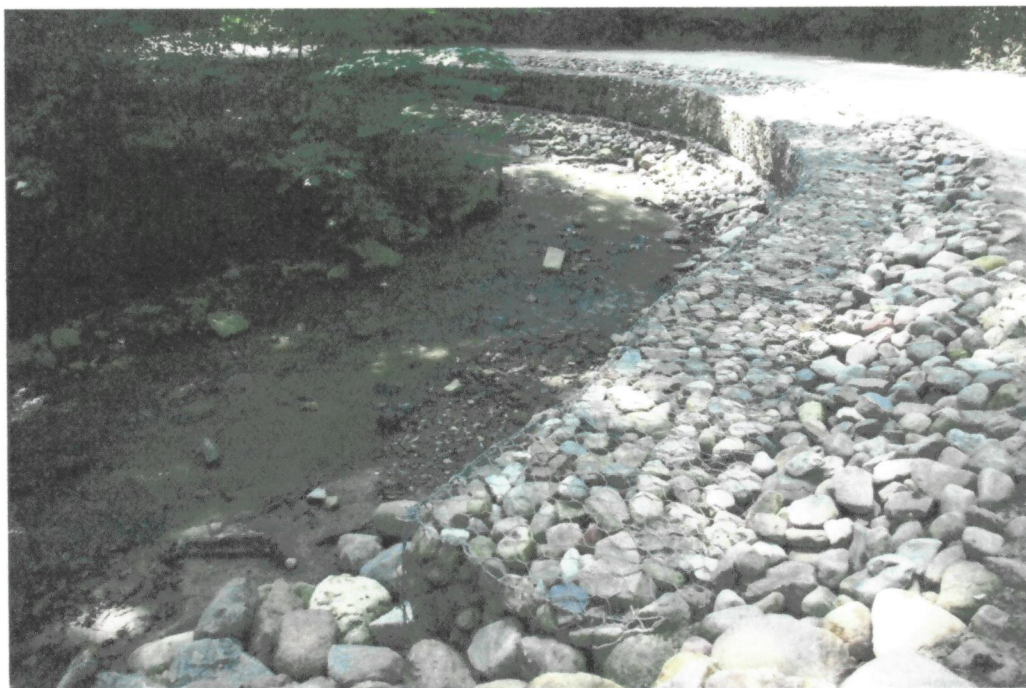
Fot. 6. Umocnienia całego brzegu prawego gabionami siatkowo-kamiennymi - odcinek III
