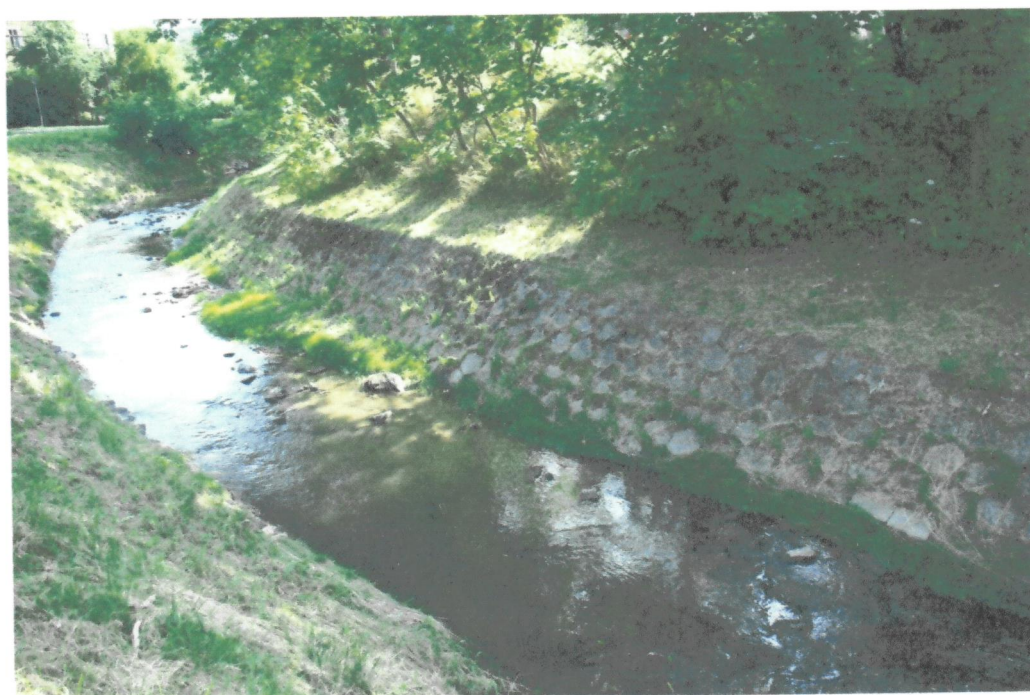
Fot. 11. Umocnienia brzegu bloczkami betonowymi (tzw. trylinka)– odcinek I
