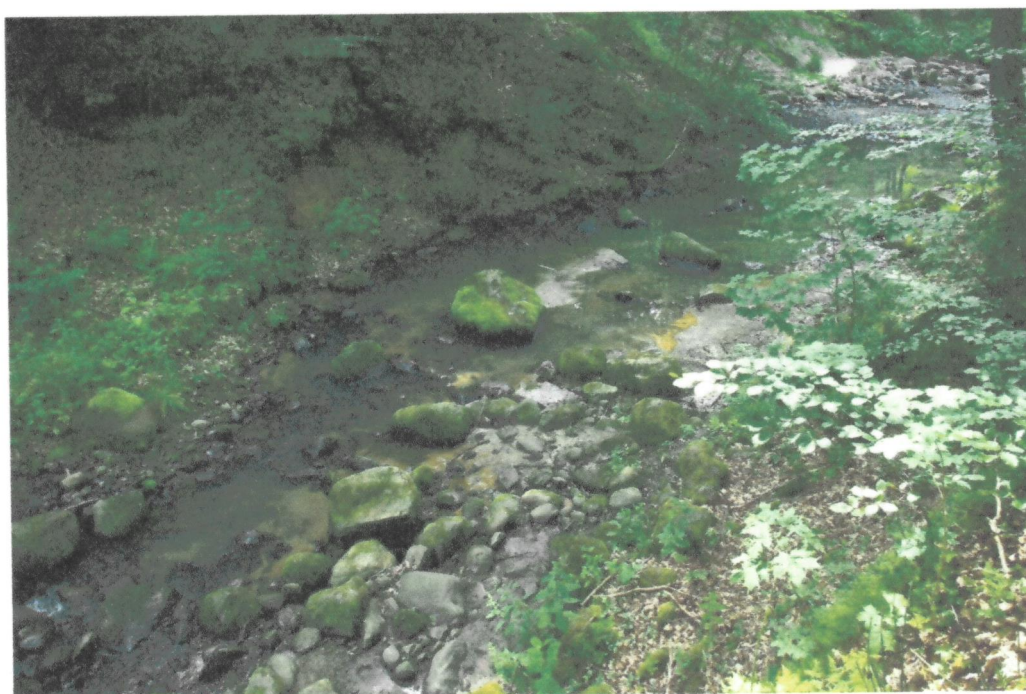
Fot. 1. Erozja brzegowa na lewym brzegu, zróżnicowany skład podłoża – odcinek IV
