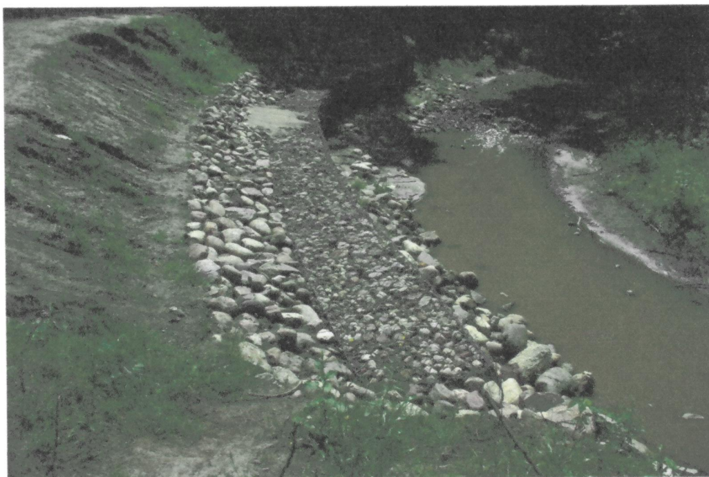
Fot. 7. Umocnienie częściowe brzegu gabionami siatkowo-kamiennymi - odcinek III
